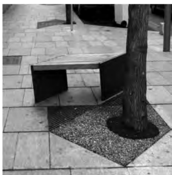
Figura 3.21: Banco con vértice peligroso.
