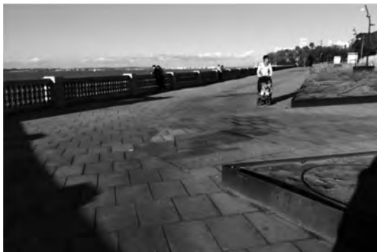
Figura 5.28: Vértices peligrosos de acero corten.
