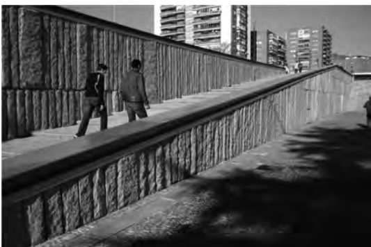
Figura 5.14: Escalirampas costosas por exceso de materiales, bordes, encintados y bordillos, Madrid Río.
