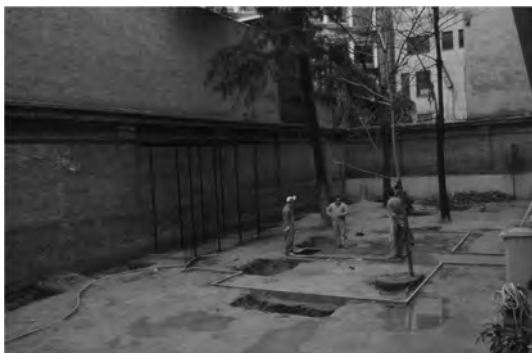
Figura 6.11: Pequeño patio antes de la obra, Madrid.
