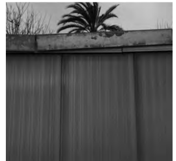
Figura 5.32: Canalón roto.
