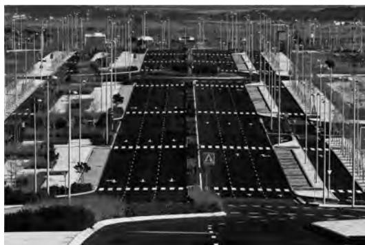
Figura 5.4: Viales sobredimensionados y farolas, Valdebebas.
