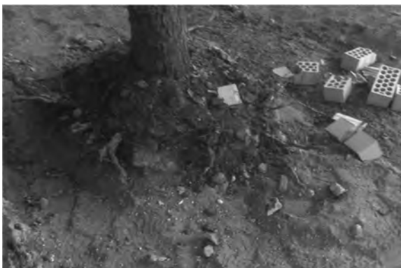
Figura 3.13: Raíces cortadas para bajar el nivel del suelo original.
